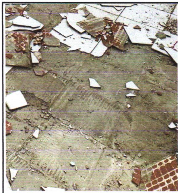
FOTO - 23 DEMOLIÇÃO DE PISO DE FORMA MANUAL, SEM REAPROVEITAMENTO
